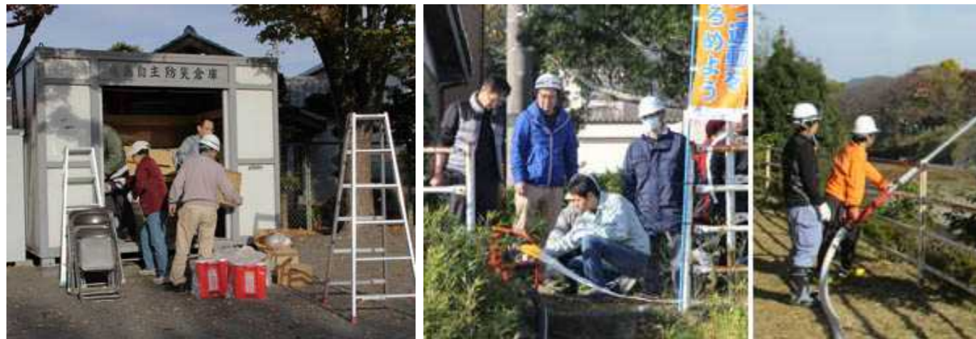
防災倉庫の点検＝鬼島公園
